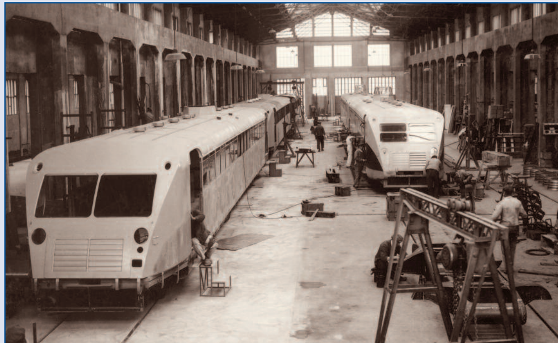
L'atelier de montage des automotrices dans l'usine Bugatti avec, à gauche sur la photo, un WLG "surallongé" en cours d'assemblage. The assembly workshop in the Bugatti factory. On the left a WLG 'surallongé' under assembly.
